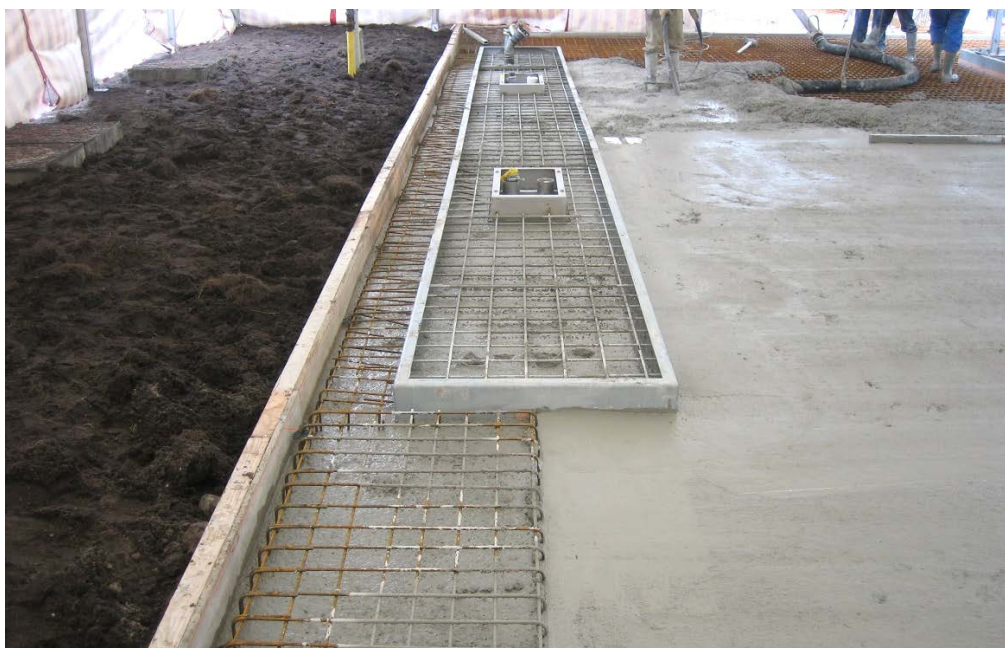
Foto: Aanbrengen van een betonverharding.
